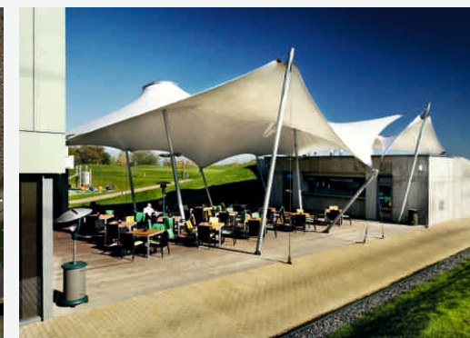
GOLFOVÉ HRŠTĚ HOSTIVAŘ, PRAHA MEMBRÁNOVÉ ZASTŘEŠENÍ RESTAURACE ARCHTEX®
