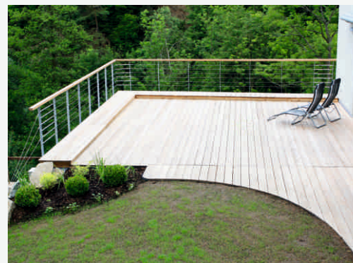
TERASA RODINNÉHO DOMU, ČR LANOVÉ SESTAVY I-SYS®
