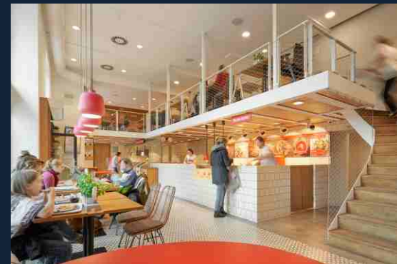
PIZZA 360, PRAHA DEJVICE (NEREZOVÉ SÍTĚ X-TEND® WHITE MW80/1,5) INTERIÉR, SCHODIŠTĚ, ZABRÁNĚNÍ PÁDU OSOB, ZÁBRADLÍ
