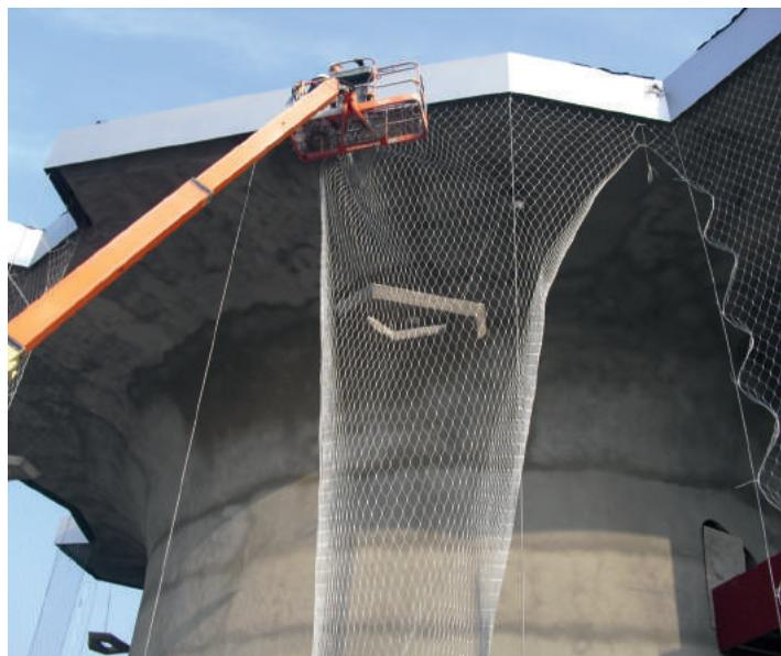
Die einzelnen Netzbahnen von X-LED Mesh 7.5 können nahtlos zusammengefügt werden, es gibt keine Größeneinschränkungen. So sind große Spannweiten und Flächen ohne Zwischenbefestigung möglich. Das Stahlseilnetz wird nur umlaufend am Rand befestigt. Es hat eine hohe Festigkeit und besitzt eine Europäisch Technische Zulassung. Die einzelnen Systemkomponenten lassen sich einfach handhaben und sind schnell montiert.
