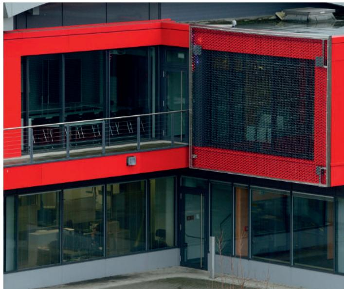
Das LED-Netz erreicht eine Transparenz von 71 bis 94 %. Bei Installation vor einer Glasfassade dringt so noch genügend Tageslicht in das Gebäude und die Sicht nach draußen ist kaum eingeschränkt. Ein weiterer Vorteil: Das LED-Netz hat wenig Eigengewicht und bietet nur eine geringe Windangriffsfläche. Deshalb müssen auch nur geringe Lasten statisch berücksichtigt werden.
