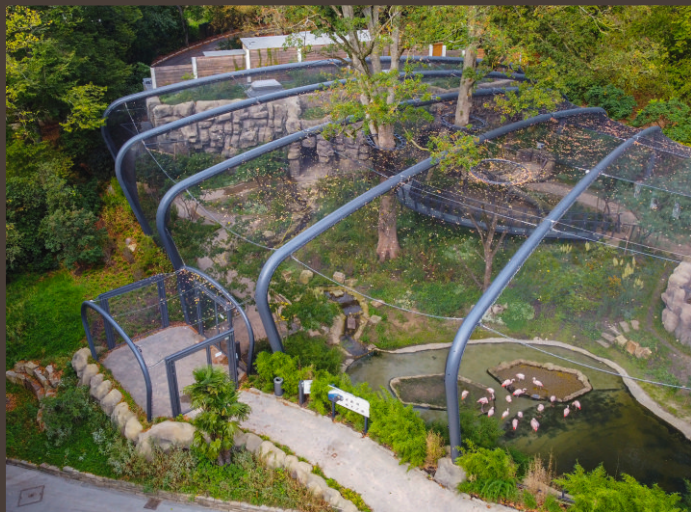
VOLIÉRA PRO PAPOUŠKY | ZOO WUPPERTAL NEREZOVÁ SÍŤ X-TEND® CXE ČERNÁ, \diamond 30 mm, \varnothing 1,5 mm, \varnothing 2,5 mm, 1 700 m 2
