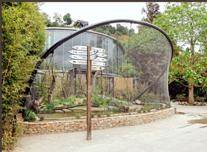
VOLIÉRA PTÁKŮ U PAVILONU SEČUÁN | ZOO PRAHA NEREZOVÁ SÍŤ X-TEND® CXE ČERNÁ, \diamond 25 mm, \varnothing 1,5 mm, 240 m 2
