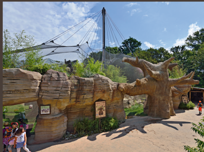
VÝBĚH ŠIMPANZŮ | ZOO HANNOVER NEREZOVÁ SÍŤ X-TEND® CXE ČERNÁ, \diamond 60 mm, \varnothing 3 mm, 1 430 m 2 / I-SYS, \varnothing 18 mm, \varnothing 22 mm, \varnothing 26 mm
