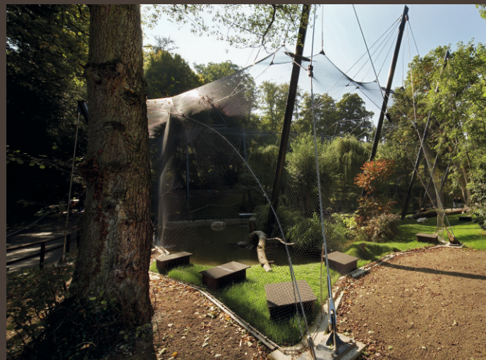
VOLIÉRA PTÁKŮ | ZOO KRONBERG NEREZOVÁ SÍŤ X-TEND® CXE ČERNÁ, \diamond 40 mm, \varnothing 1,5 mm, \varnothing 2 mm, 3 000 m 2 / I-SYS, \varnothing 10 mm
