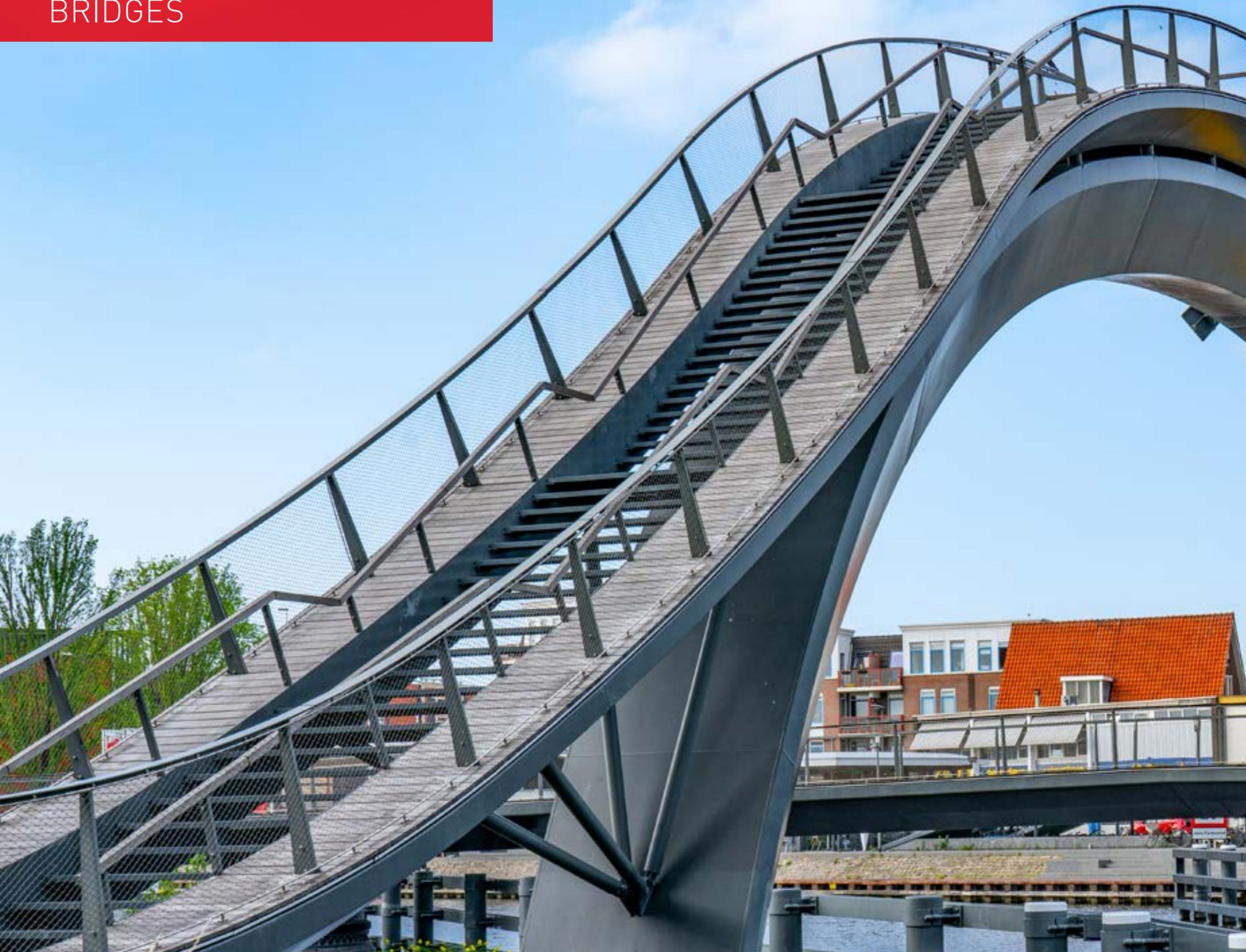
Geländerfüllungen mit X-TEND sind auf die Sicherheits- und baurechtlichen Bestimmungen beim Brückenbau abgestimmt. Auch als vertikale Absturzsicherungen, Suizidschutz sowie Überwurfschutz wird X-TEND eingesetzt.
