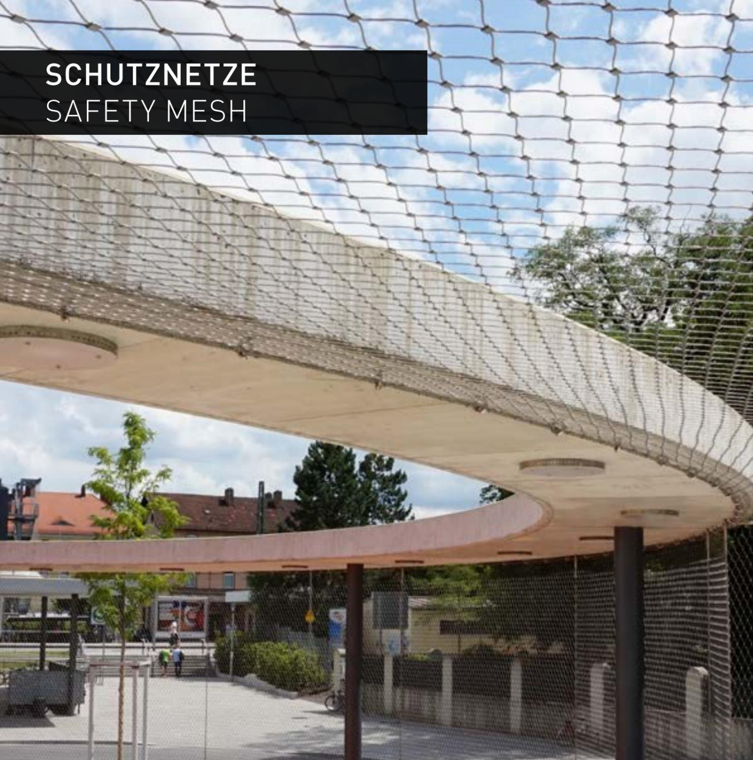
Schutznetze dienen nicht ausschließlich der Absturzicherung. Als Ballfangnetze, Wurf- oder Vogelschutz schützen sie Mensch, Tier und Gegenstände inner- und außerhalb des eingezäunten Bereichs vor unerwünschtem Eindringen oder Ausbrechen. So verhindern beispielsweise Schutznetze, dass Drohnen in sicherheitskritische Bereiche eindringen oder gefährliche Gegenstände diese Bereiche verlassen.
