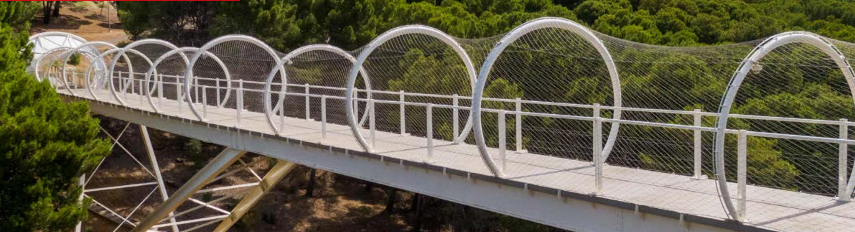
Die Sanierung der aus den 1960er Jahren stammenden alten Rad- und Fußgängerbrücke zwischen zwei Campusbereichen der Flinders University, stellte besondere Anforderungen an Sicherheit, Bauzeit und Tragfähigkeit der 64 Meter langen Brücke.
