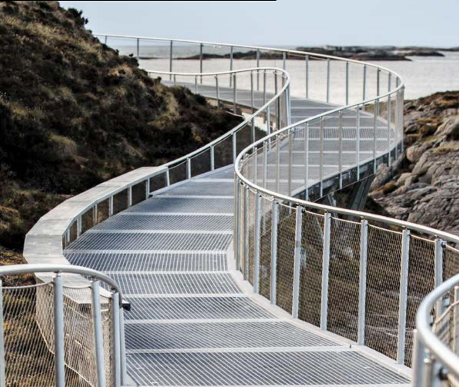
Geländerfüllungen zur Absturzsicherung an Balkonen und Wegen lassen sich filigran, unauffällig und sicher mit X-TEND Edelstahl-Seilnetzsystemen ausführen. Die Leichtigkeit der Konstruktion und die Langlebigkeit der Materialien überzeugen Planer und Nutzer. Mit dem Baukastensystem I-SYS und den unterschiedlichen Maschenweiten von X-TEND eröffnen sich zahlreiche Gestaltungsmöglichkeiten.
