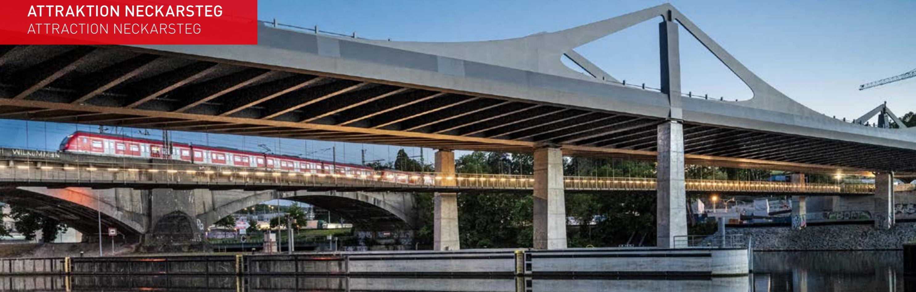
Im Rahmen von „Stuttgart 21“ musste, die 1977 erbaute Neckarbrücke, dem modernen Bahnprojekt weichen. Der neue Neckarsteg ist für Fußgänger und Radfahrer. Sie hängt unter der Eisenbahnbrücke, die zwischen dem Hauptbahnhof Stuttgart und dem Bahnhof Stuttgart-Bad Cannstatt gebaut wurde. Mit knapp 170 Metern Länge und einer Breite von 4,5 Metern ist sie etwas größer und schwebt ca. 6 Meter über dem Neckar.
