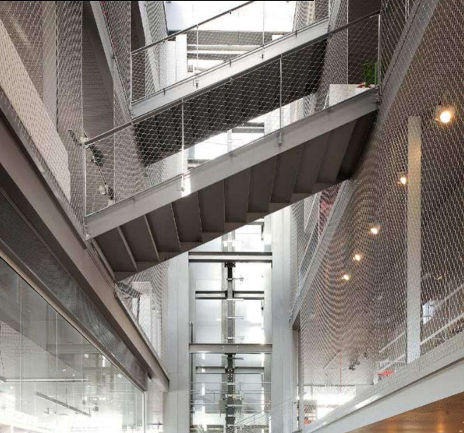
X-TEND Seilnetzsysteme sind eine leichte und transparente Möglichkeit der Absturzsicherung. Durch die hohe Transparenz ist eine flächendeckende Sicherung ohne oder mit nur geringer Einschränkung der Sicht sowie mit hoher Licht- und Luftdurchlässigkeit möglich. Durch das geringe Gewicht können sie im Gegensatz zu massiven Gebäudeverkleidungen auch in der Leichtbauarchitektur angewendet werden.
