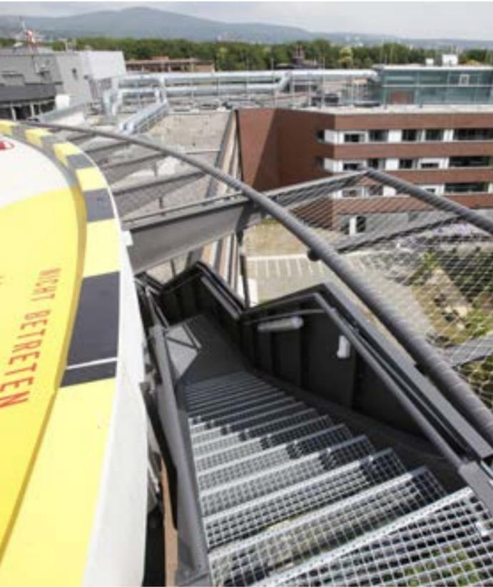
Horizontale Sicherungen werden überall dort eingesetzt, wo keine vertikale Absicherung gewünscht ist oder ausgeführt werden kann. Beispielsweise bei Hubschrauberlandeplätzen und als zusätzliche Absicherung von horizontalen Deckenöffnungen und Treppenaugen. Auf Wunsch liefert CARL STAHL ARCHITEKTUR darüber hinaus eine prüffähige statische Berechnung und bietet eine fachgerechte Montage der Seilnetze.
